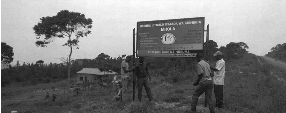
Beim Aufstellen des Schildes für das neue Community Center.
